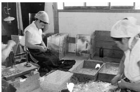
写真1. 板ガラスからレンズ玉を打ち抜く様子（ニッポンレンズ提供）
